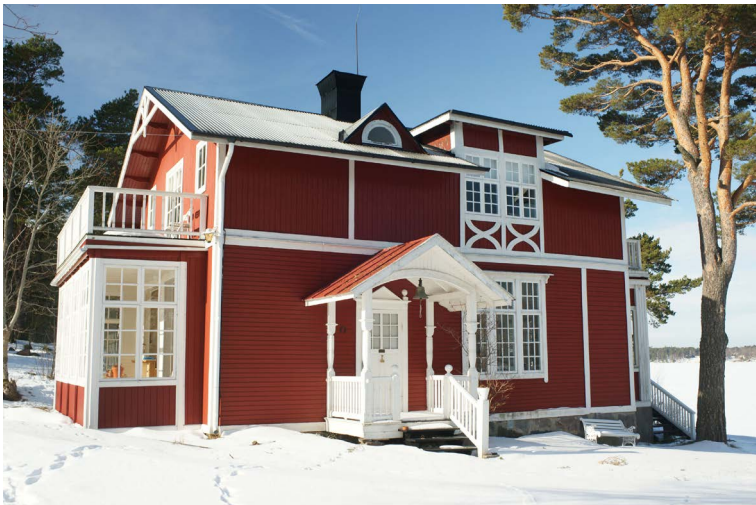
En av Barnviks sommarvillor med många från tiden typiska stildrag, exempelvis verandor och fastukvistar asymmetriskt placerade på byggnadskroppen, stående och liggande panel indelat av våningslist samt fonrnordiska stildrag i fasadernas få men utmärkande dekorationer.
